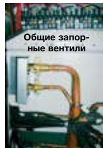
В наружных блоках (модели 1:4 и 1:5) помимо выходных портов для каждого внутреннего блока есть два общих запорных вентиля, через которые удобно осуществлять вакуумирование и дозаправку системы, а также проводить измерения высокого и низкого давления в системе.
